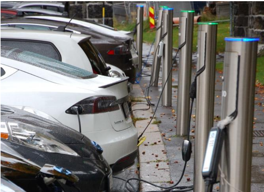
Kuva 38. Sähköautojen puolinopeita julkisia peruslatauspisteitä Oslossa kadunvarrella (kuva: Sitowise Oy).
