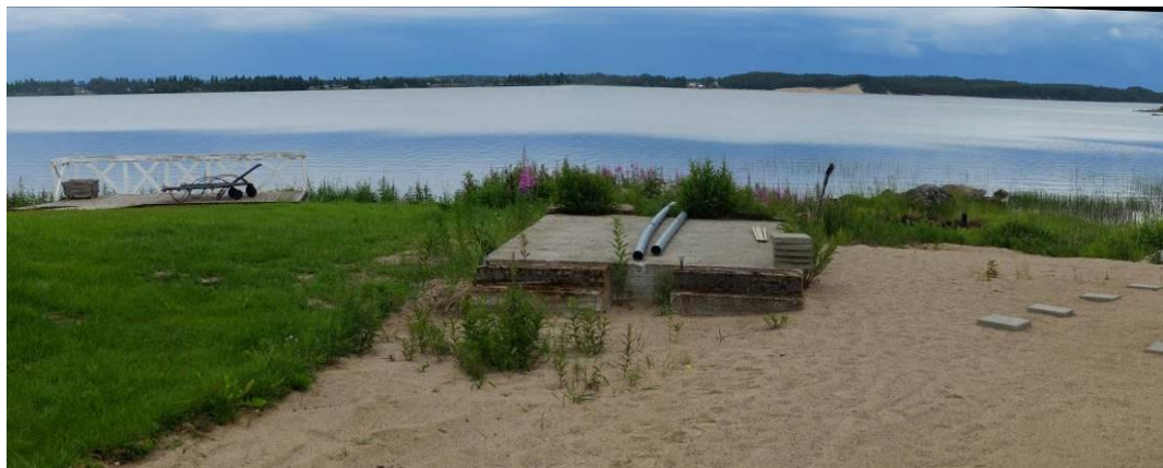
Kuva 11 Uusi sauna tulee vanhalle perustukselle
