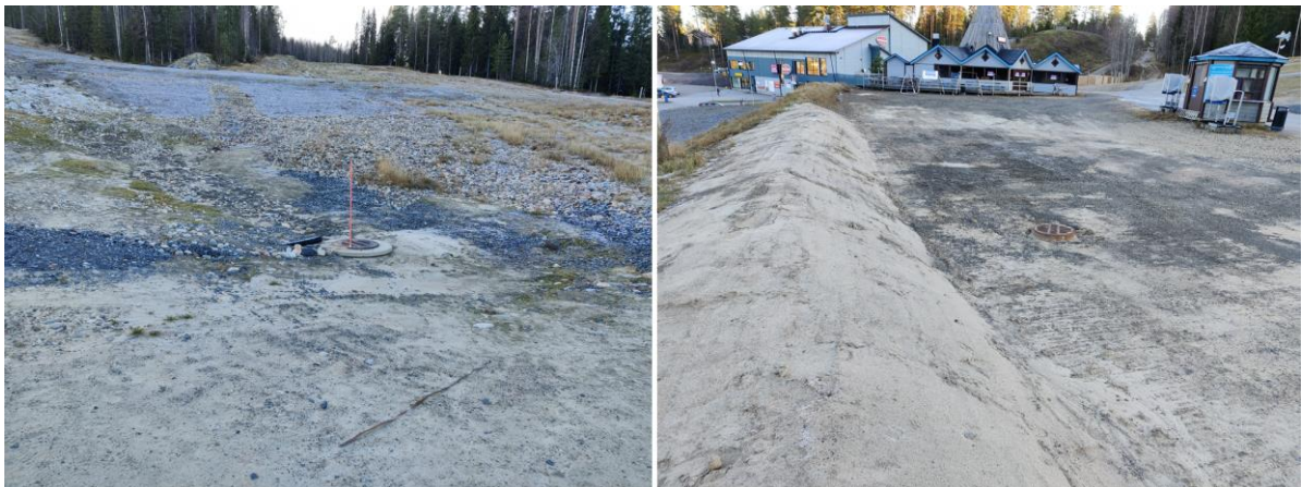
Kuva 14. Hulevesikaivot valuma-alueen alaosassa.
