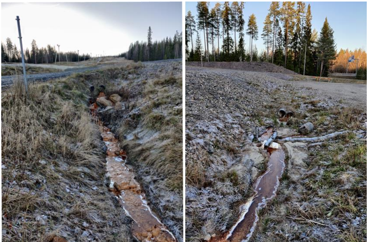
Kuva 9. Hulevesien purkureitti viivytysaltaaseen valuma-alueen 1.2 länsipuolella.
