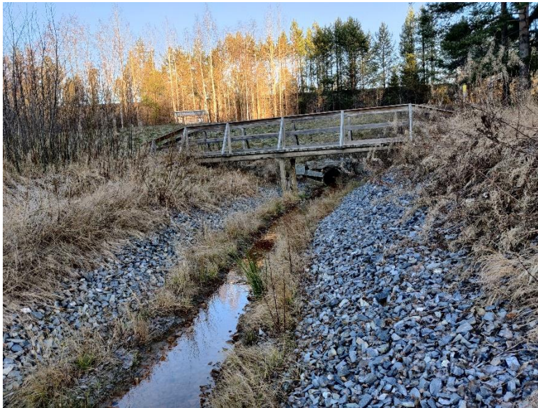
Kuva 2. Hulevesien purkureitti ja Vuokatintien alittava 800B rumpu.
