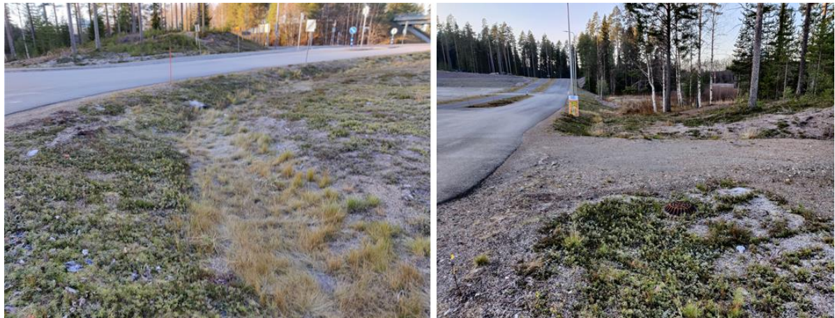
Kuva 11. Ilkantien pohjoispuolen idästä tuleva hulevesireitti.
