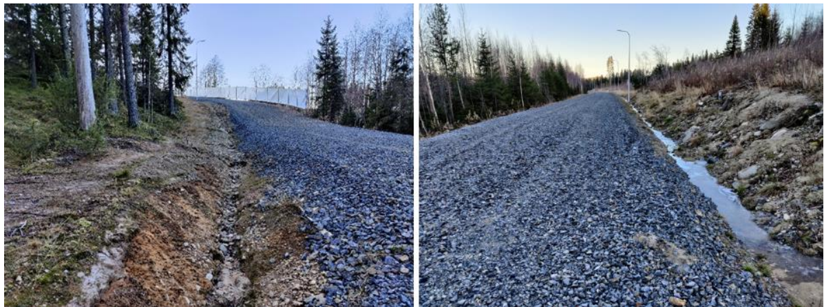
Kuva 3. Latupohjan/ulkoilureitin reunaoja.
