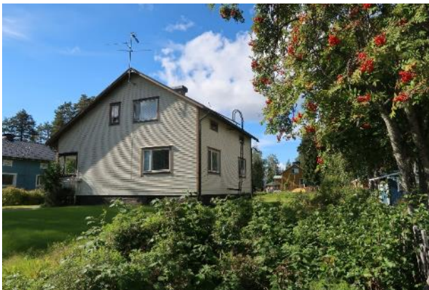
Asuinrakennus pihan puolelta.
