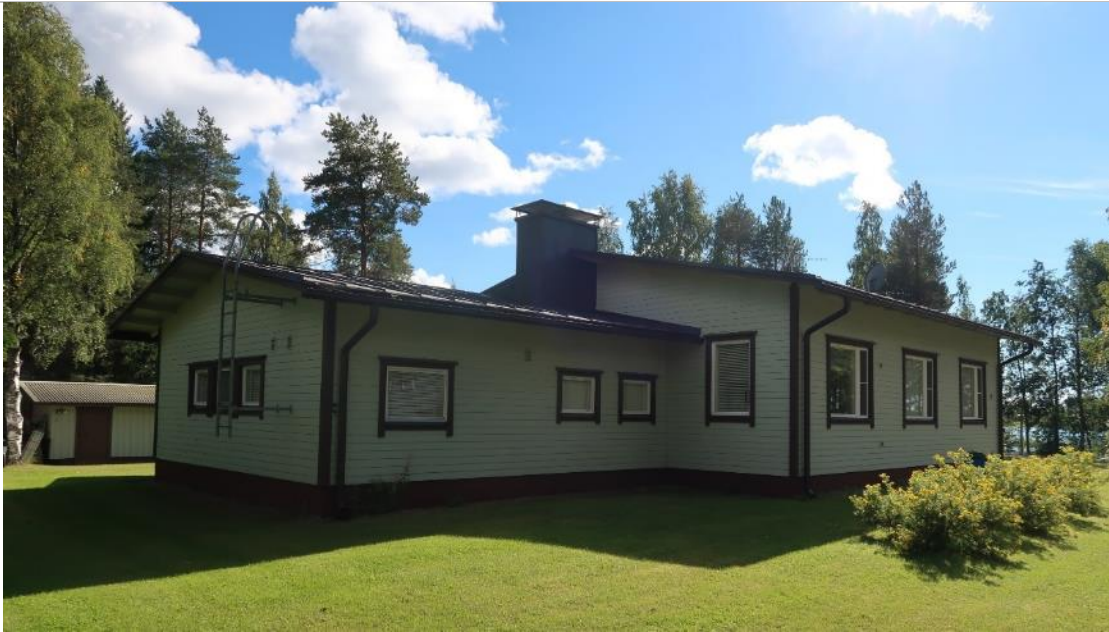
Rakennuksen Saaritien puoleinen julkisivu.
