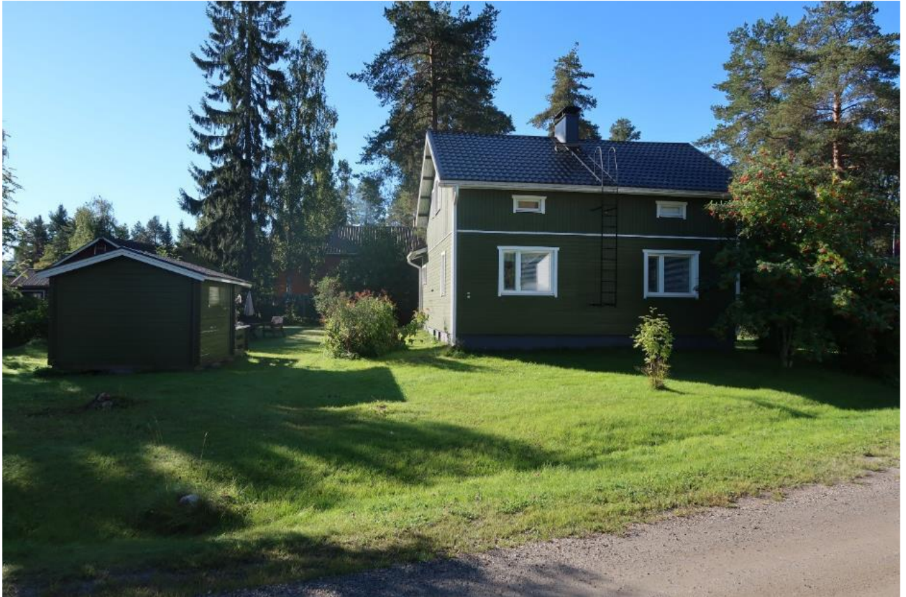
Saaritie 36:ssa sijaitseva asuinrakennus pihapiireineen on säilynyt alkuperäisen mittakaavan mukaisena. Rakennukseen on vuosien saatossa tehty saneerauksia, mutta yleisilmeeltään se on säilynyt autenttisena.
