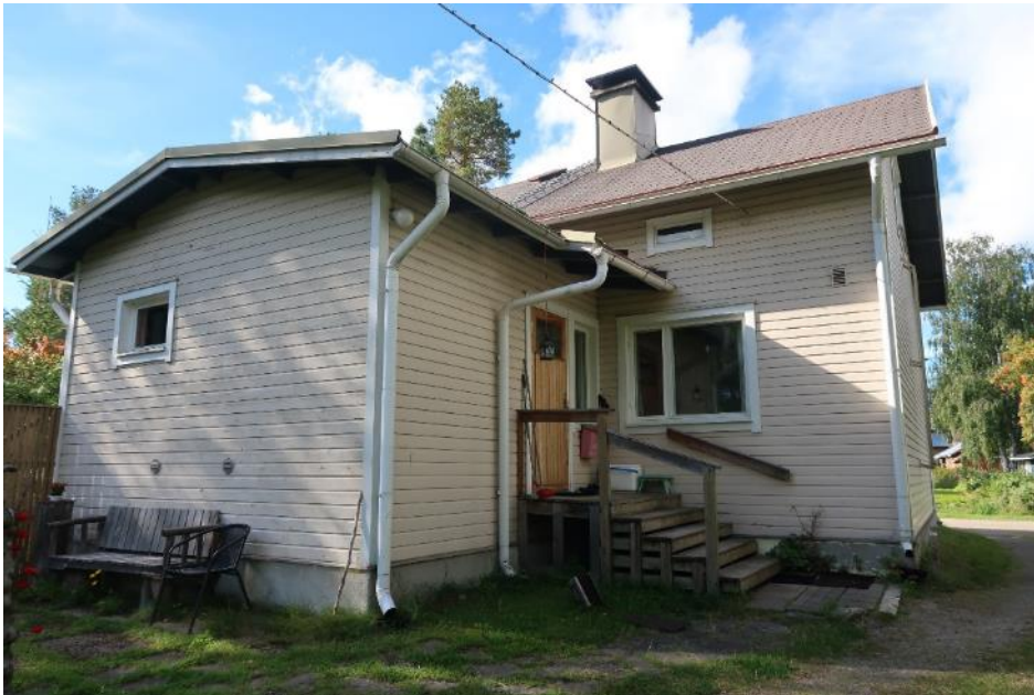
Rakennus sisäpihan puolelta. Laajennusosa etualalla.
