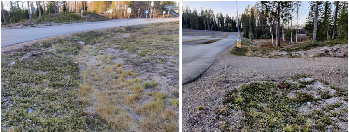
Kuva 11. Ilkantien pohjoispuolen idästä tuleva hulevesireitti.
