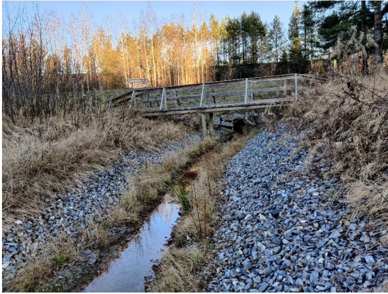
Kuva 2. Hulevesien purkureitti ja Vuokatintien alittava 800B rumpu.
