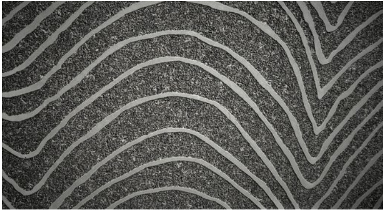
Kuva 5. Esimerkki graafisesta betonipinnasta
