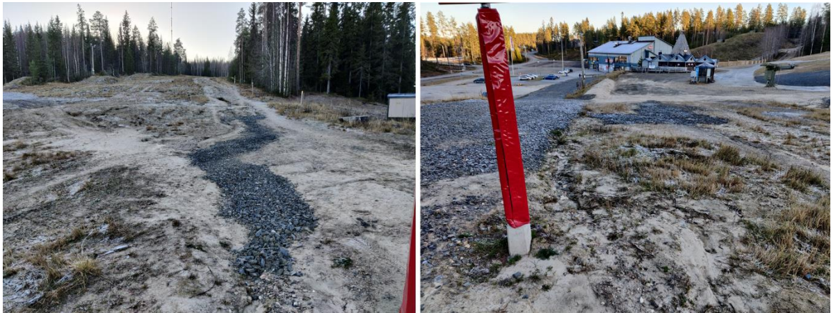
Kuva 13. Hulevesien virtausreitti länsipuolen rinnealueelta.
