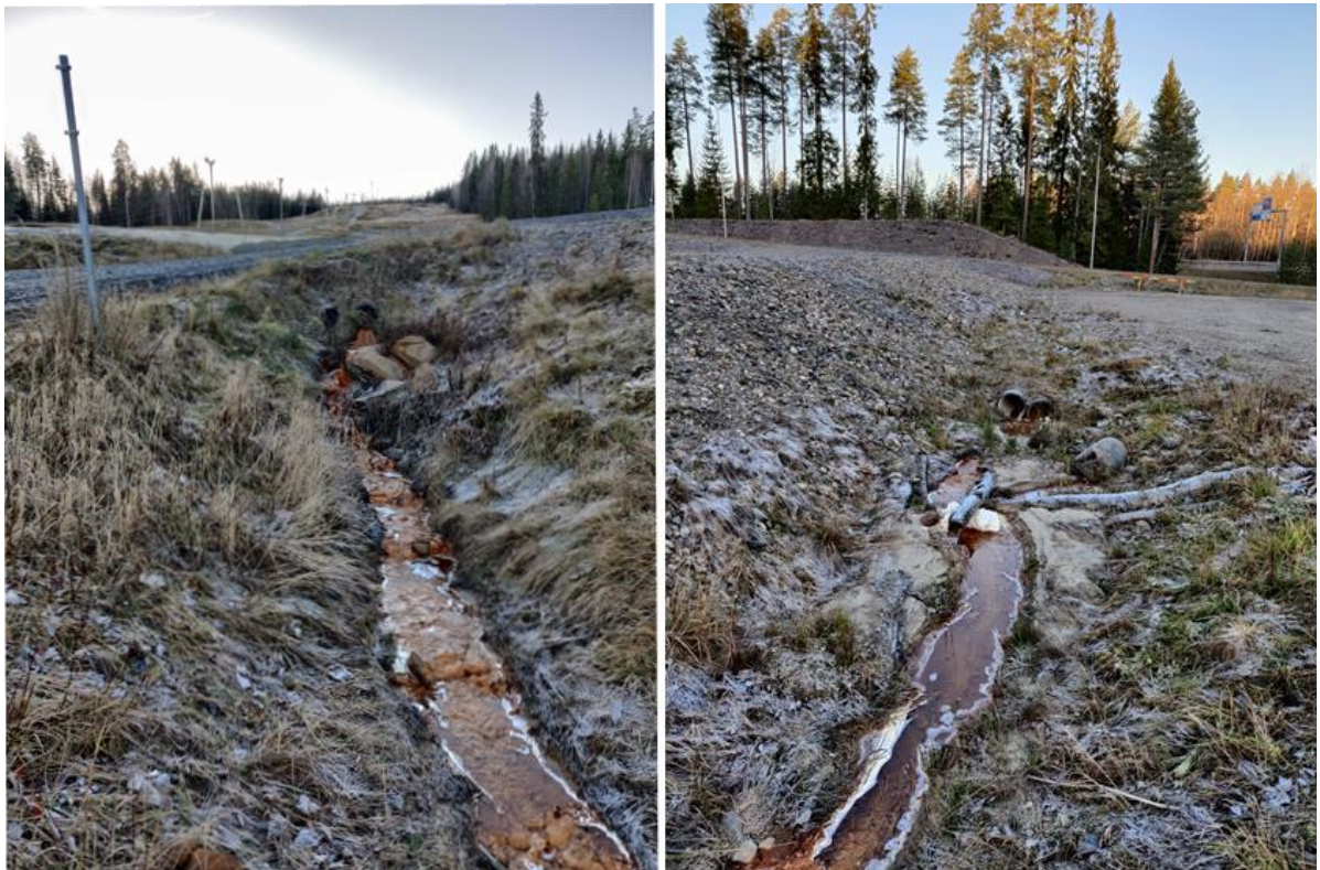
Kuva 9. Hulevesien purkureitti viivytysaltaaseen valuma-alueen 1.2 länsipuolella.
