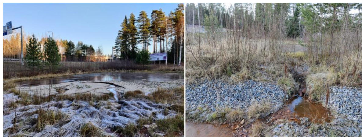
Kuva 5. Hulevesien viivytysallas (vasen näkymä lounaiskulmasta, oikea idästä)
