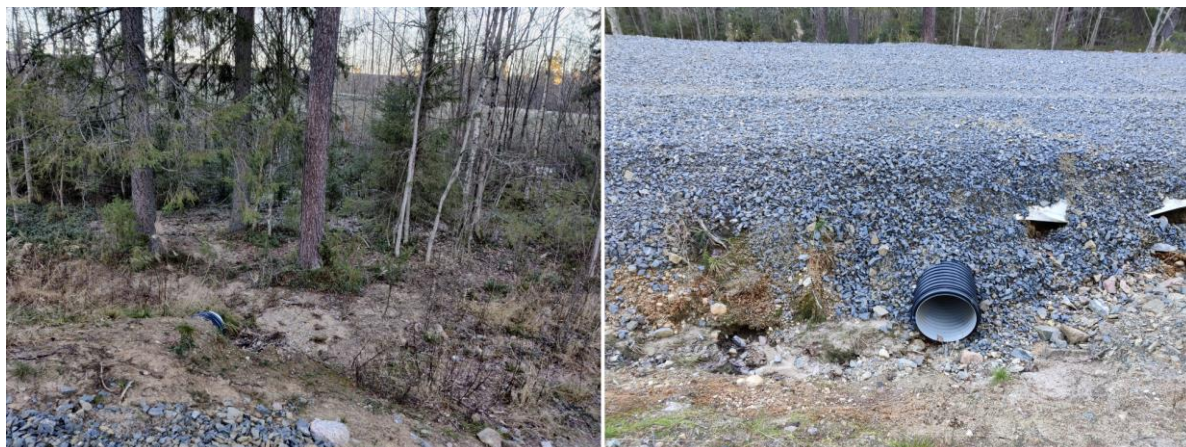
Kuva 4. Latupohjan/ulkoilureitin alittava rumpu (~400 mm).
