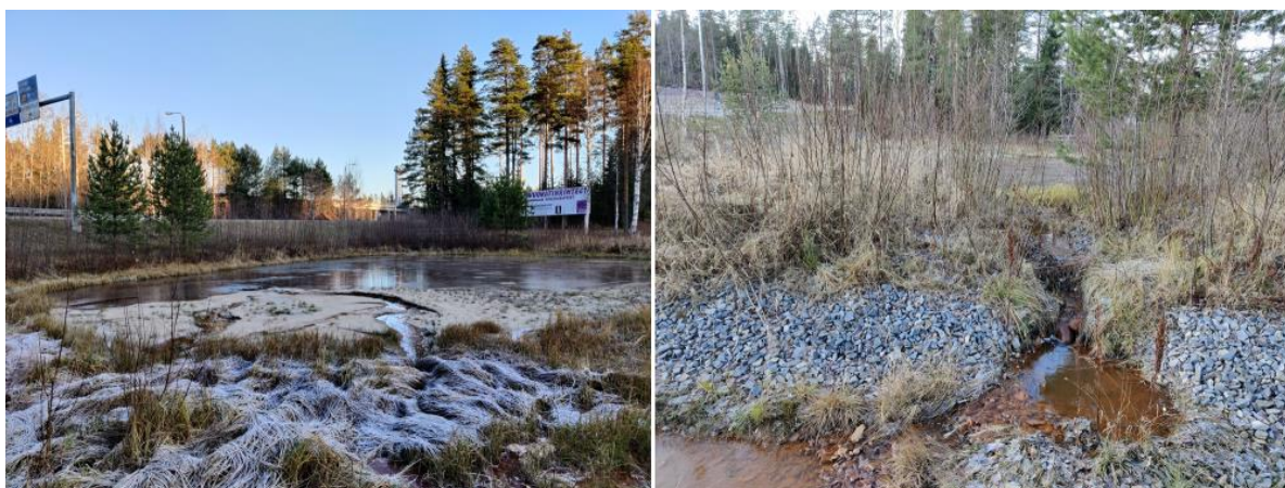
Kuva 5. Hulevesien viivytysallas (vasen näkymä lounaiskulmasta, oikea idästä)
