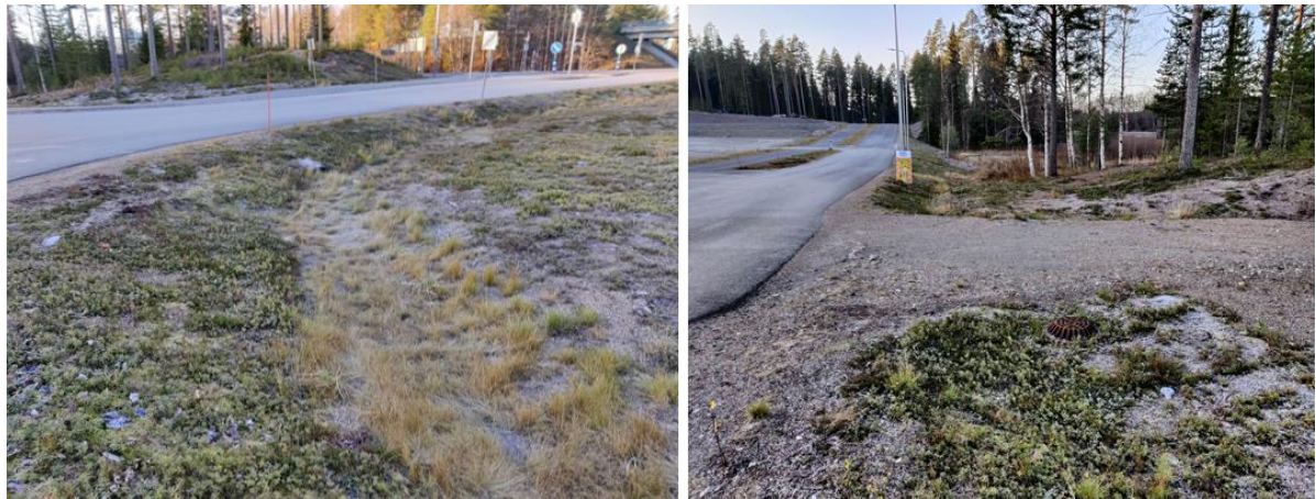
Kuva 11. Ilkantien pohjoispuolen idästä tuleva hulevesireitti.
