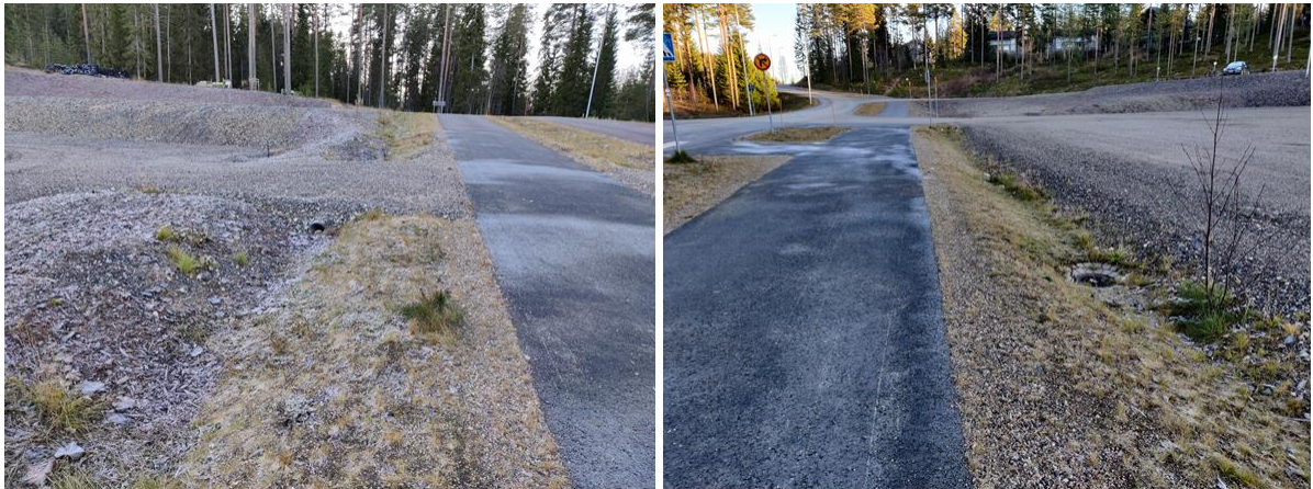
Kuva 10. Hulevesireitit Ilkantien eteläpuolella (vasen länteen, oikea itään).
