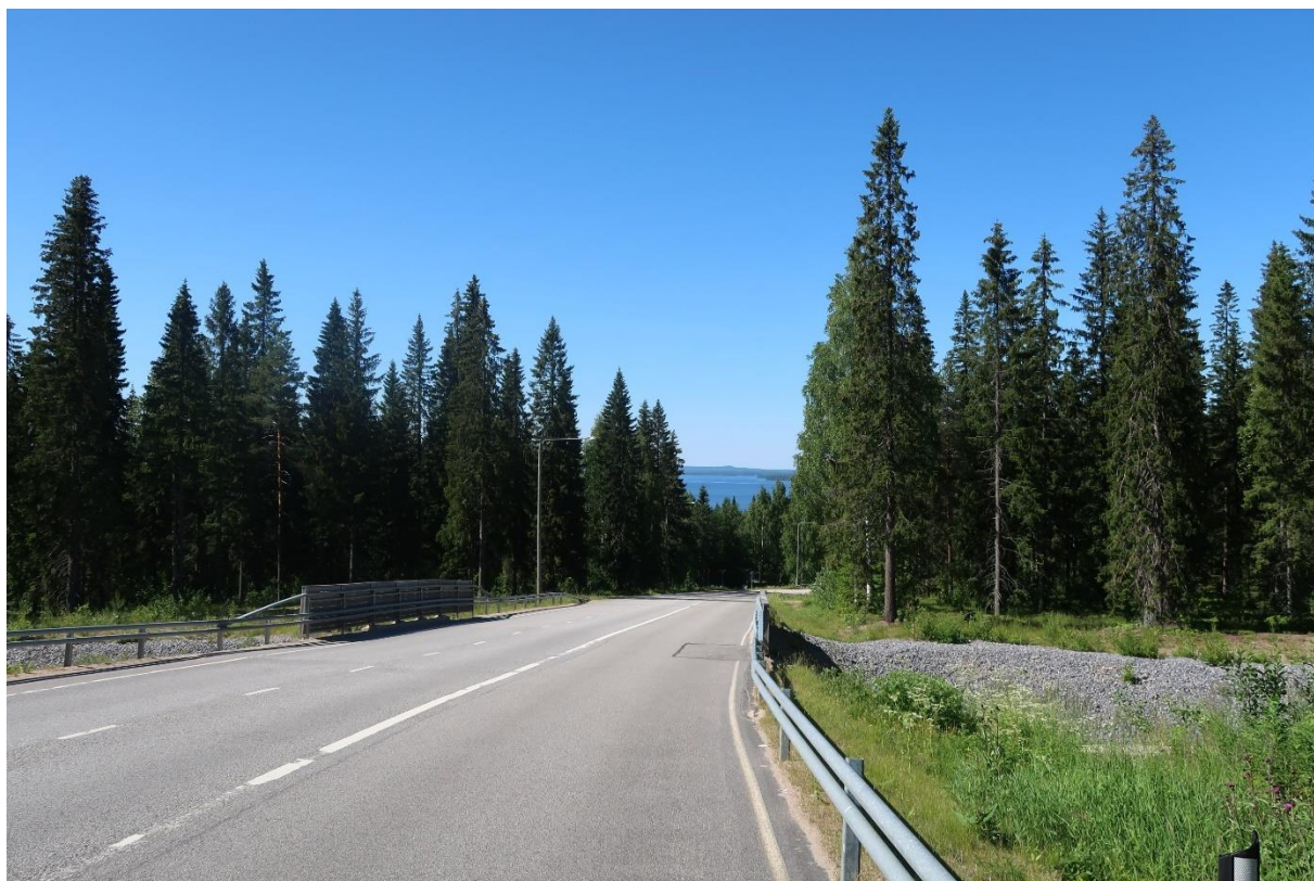
Kuva 4. Vuokatinvaaralle johtava tie latutunnelin kohdalta. Tien oikeassa laidassa rullahiihtoa varten tehty levennetyt piennar.
